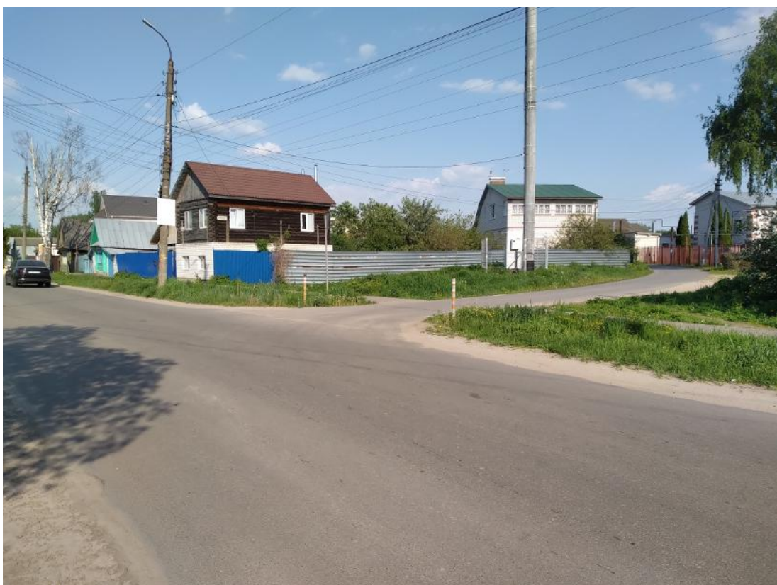
Илл. 21. Фотофиксация территории проектируемых работ по строительству/прокладке газопровода низкого давления. Точка фотофиксации 2. Вид на трассу проектируемого газопровода и на место расположения проектируемого рабочего котлована с запад-северо-запада
