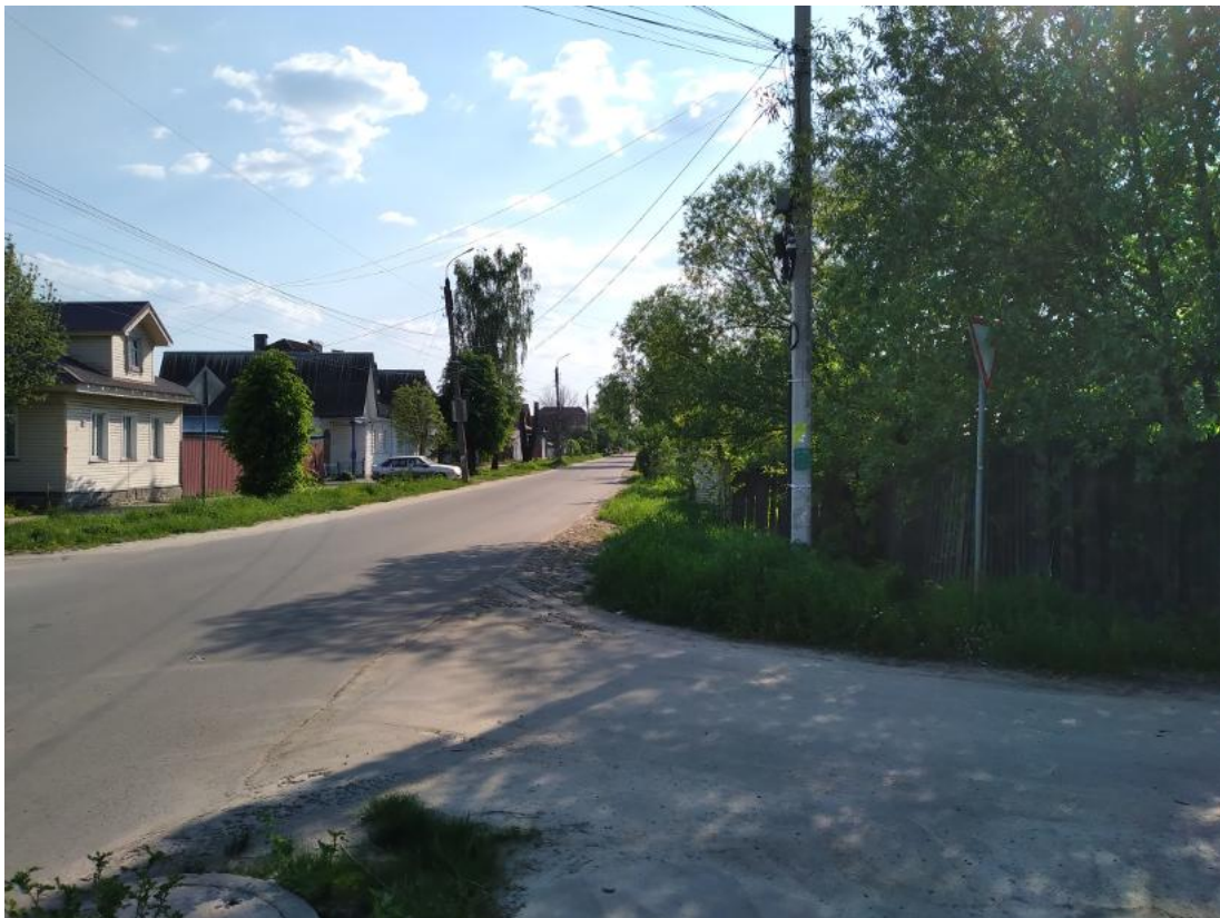
Илл. 18. Фотофиксация территории проектируемых работ по строительству/прокладке газопровода низкого давления. Точка фотофиксации 1. Вид на начало трассы проектируемого газопровода, на место расположения точки врезки в существующий подземный газорпровод и на место расположения проектируемого приемного котлована с северо-востока
