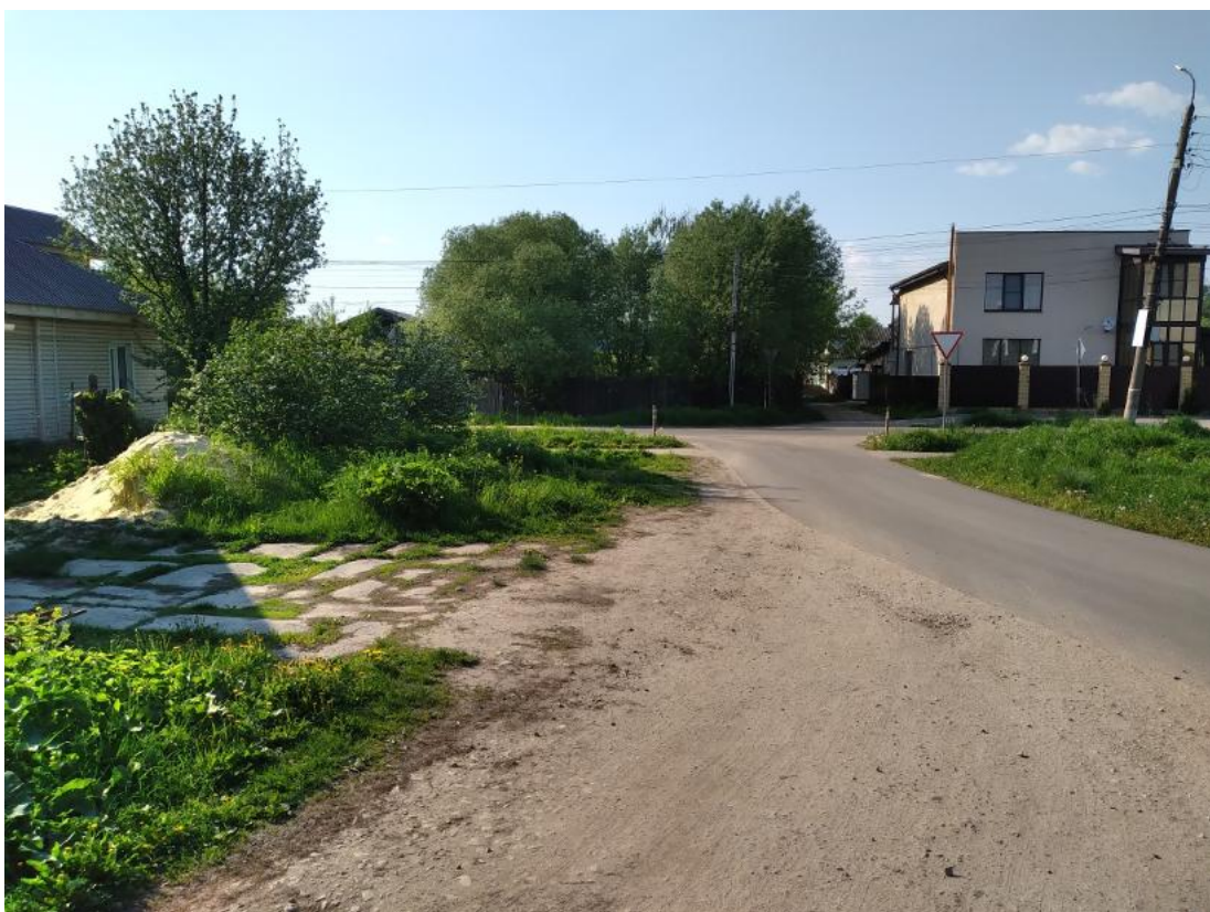
Илл. 25. Фотофиксация территории проектируемых работ по строительству/прокладке газопровода низкого давления. Точка фотофиксации 5. Вид на трассу проектируемого газопровода, на место расположения точки врезки в существующий подземный газорпровод и на места расположения проектируемых котлованов с юго-востока
