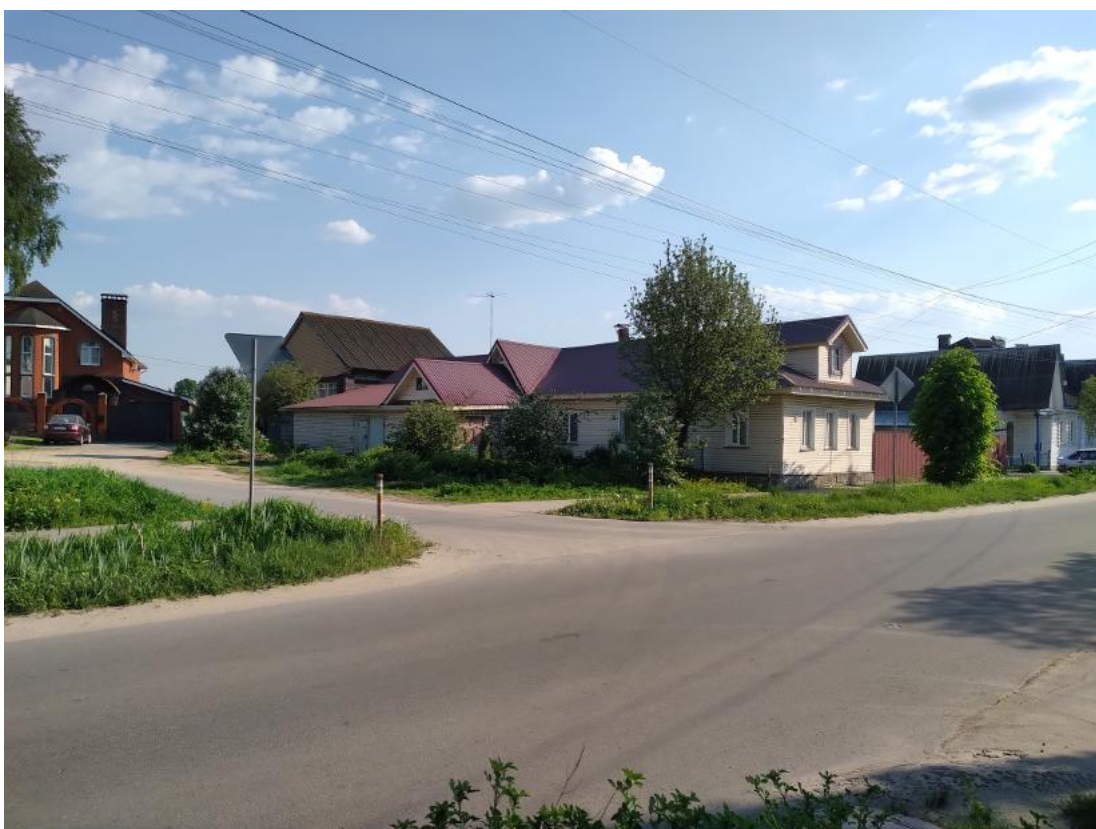
Илл. 19. Фотофиксация территории проектируемых работ по строительству/прокладке газопровода низкого давления. Точка фотофиксации 1. Вид на трассу проектируемого газопровода и на место расположения проектируемого рабочего котлована с север-северо-востока
