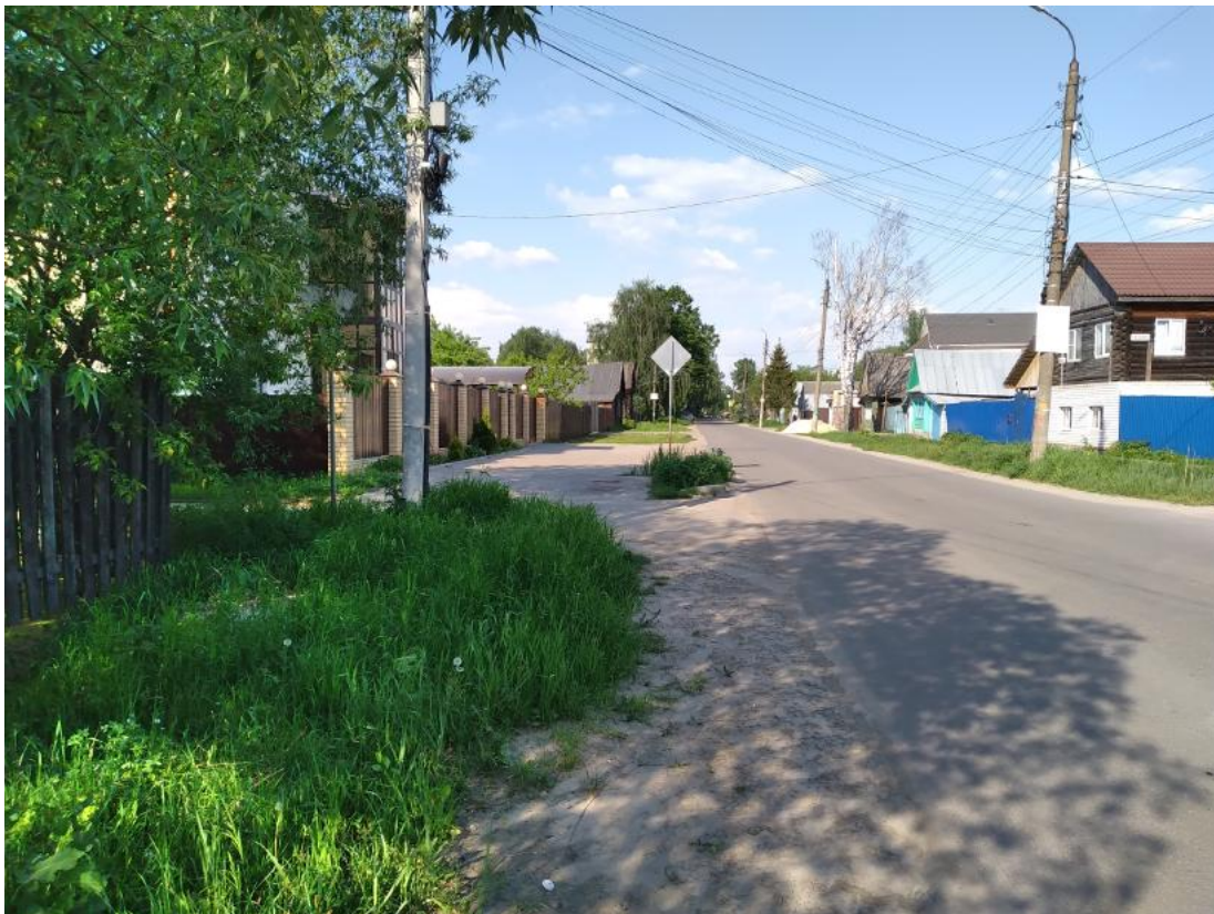
Илл. 20. Фотофиксация территории проектируемых работ по строительству/прокладке газопровода низкого давления. Точка фотофиксации 2. Вид на начало трассы проектируемого газопровода, на место расположения точки врезки в существующий подземный газорпровод и на место расположения проектируемого приемного котлована с юго-запада
