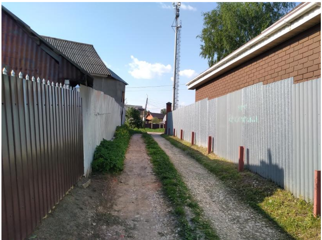
Илл. 27. Фотофиксация территории проектируемых работ по строительству/прокладке газопровода низкого давления. Точка фотофиксации 6. Вид с юг-юго-востока на конечную часть трассы проектируемого газопровода и на место расположения точки подключения объекта заявителя
